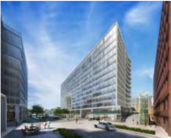
FIGURE 3. Image Source: SOM
